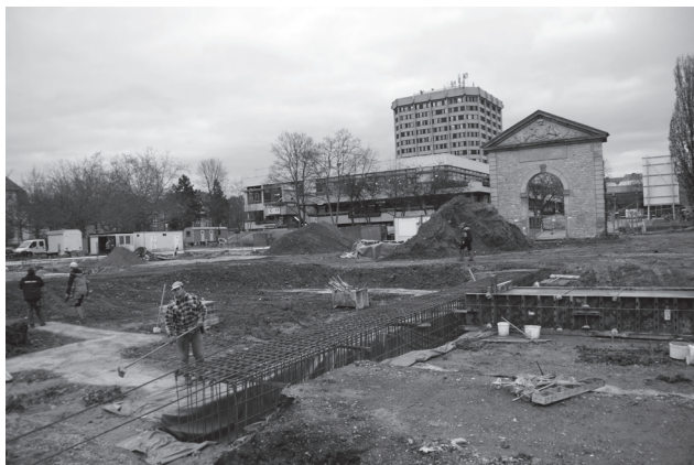
Die Baustelle direkt hinter dem Oec und der Mensa
